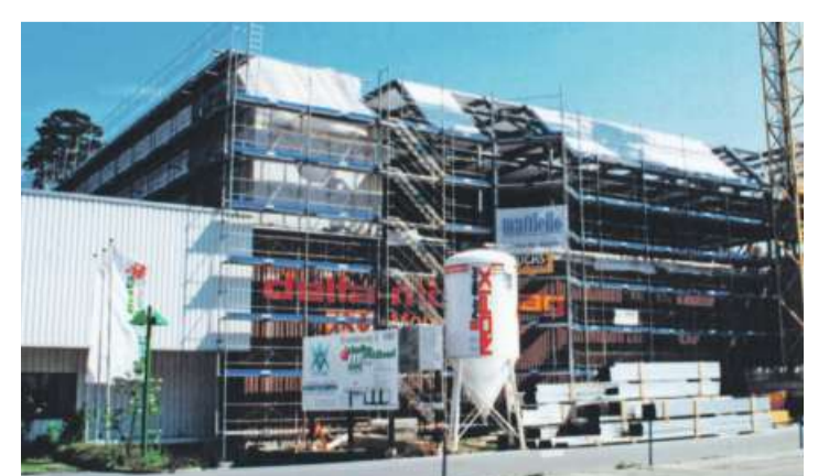
1997: Aufstockung der Hallen 3 und 4 von zwei auf vier Etagen.
